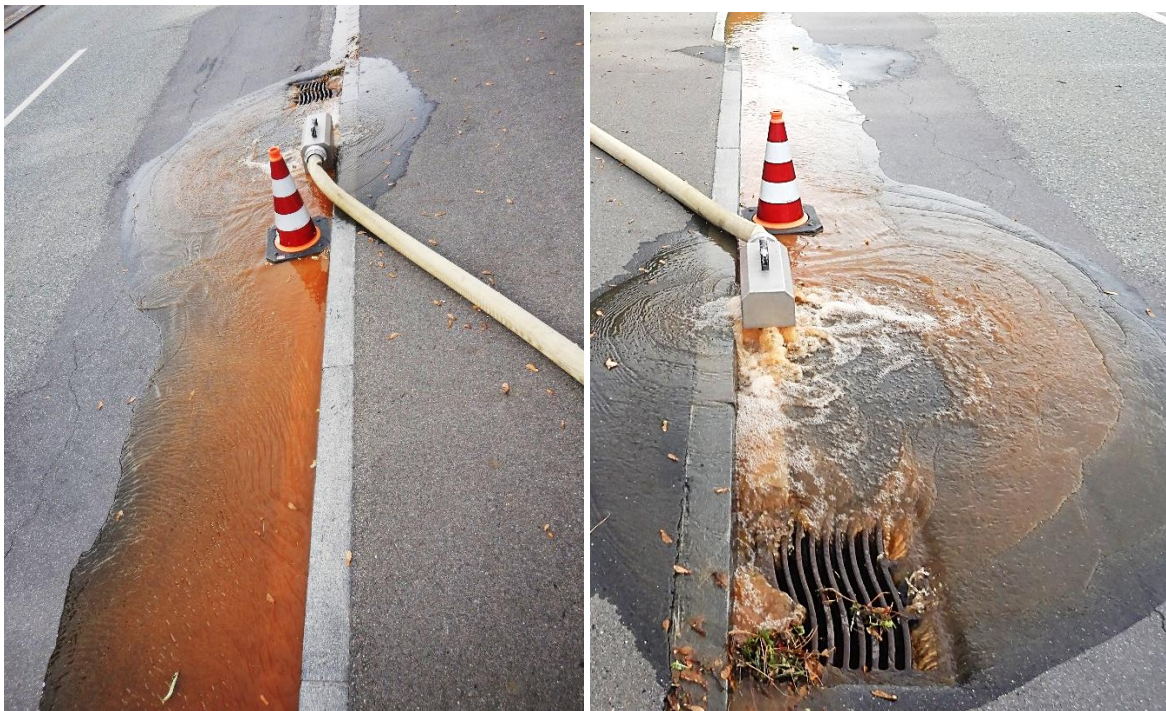
Abbildung 2: Beispiel einer Spülung mit Austrag von Ablagerungen
