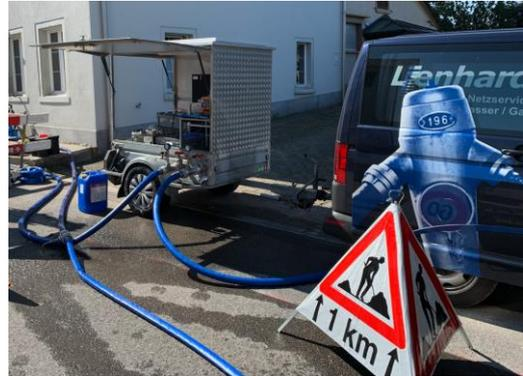
Abb. 10 und 11: Standdesinfektion von Trinkwasserschläuchen
