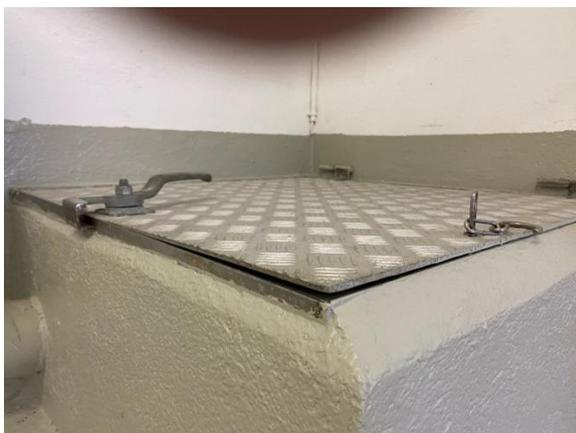
Die Belüftung der Wasserkammern soll über einen Feinfilter erfolgen. Die Abläufe der Brunnenstuben oder die Strümpfel sind siphoniert, die Belüftung erfolgt über den Filter im Deckel. Undichte Zugangsluken über der offenen Wasserfläche in Reservoiren oder offene Wasserflächen in Quellwasserpumpwerken stellen ein Bypass des Filters und daher ein Kontaminationsrisiko dar. Diese sollen baldmöglichst geschlossen und eine Belüftung über den Feinfilter erzwungen werden.
