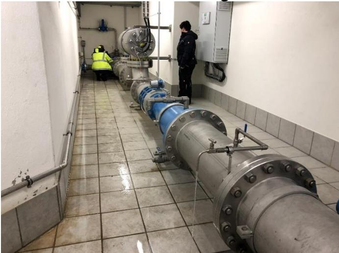
E.coli und Enterokokken sind bezüglich UV-Strahlung, sehr empfindlich. Um diese Fäkalindikatoren nicht bei der Probenahme durch Streulicht abzutöten, ist der Probenahmepunkt vor der UV-Anlage (Rohwasser) mindestens 10 Rohrdurchmesser vor dem Reaktor anzuordnen. Leider werden nach wie vor UV-Anlagen geplant und installiert, welche das Entleerungsventil als Probenahmeort definieren. Bei der Projektierung von neuen UV-
