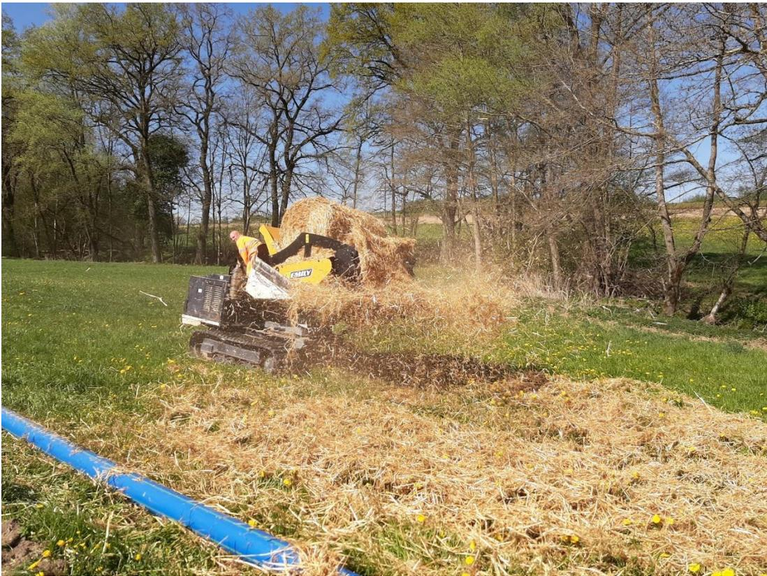
Abbildung 17: Strohstreuer für Trennschicht unter Baupiste. Foto RSW AG.
