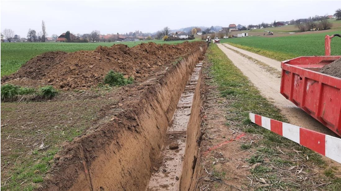
Abbildung 5: Grabenaushub mit Bodendepots (nur Ober- und Unterboden aufgrund tiefgründiger Böden). Foto RSW AG.
