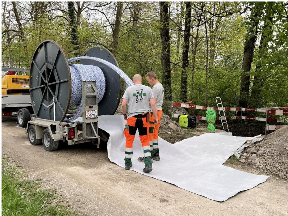
Abbildung 21: Sanierung best. Eternitleitung mit flexiblem Hochdruck Inliner. Foto: Huber Leitungsbau GmbH
