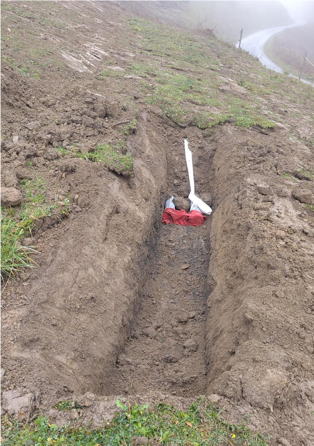
Abbildung 12: Abschnitt offener Grabenbau: Grasmattenabtrag und Aushub. Arbeiten in Tagesetappen. Foto RSW AG.
