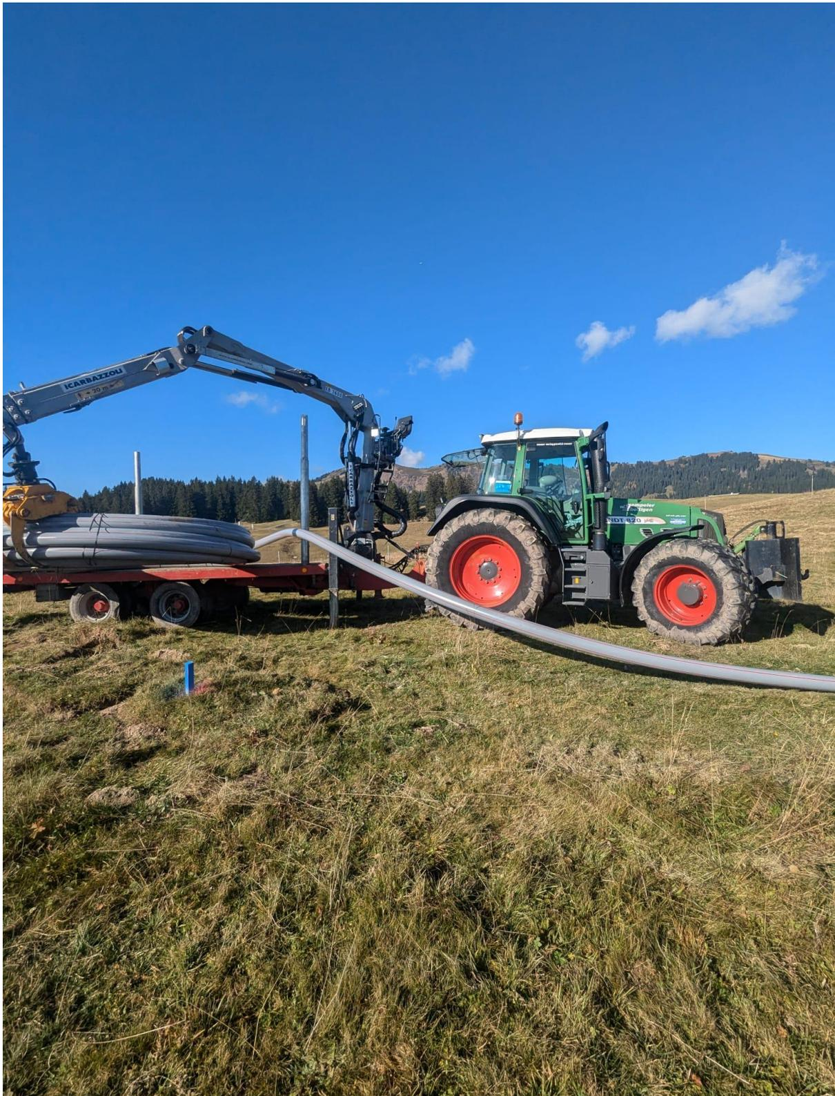
Abbildung 11: Vorbereitungsarbeiten Grabenpflug: Vorverlegen Schutzrohr mit angepasster Maschinenwahl. Foto RSW AG.
