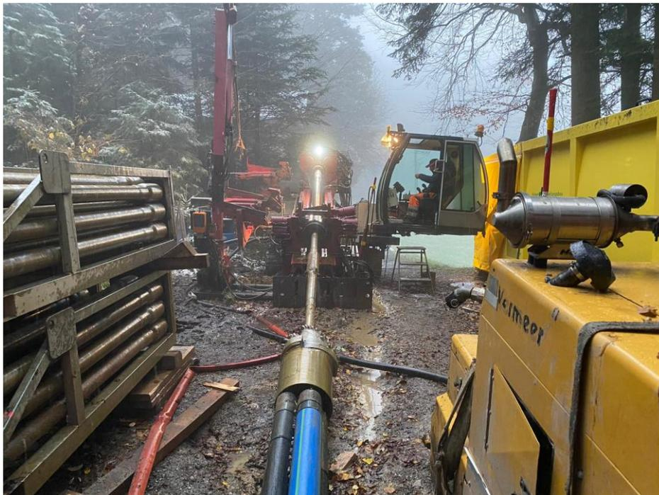
Abbildung 25: Spülbohrung unter engen Platzverhältnissen Krienseregg. Foto: Huber Leitungsbau GmbH
