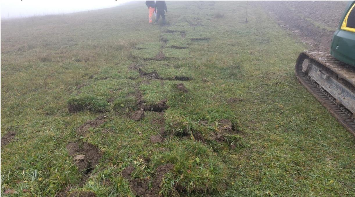
Abbildung 8: Sauberer Grasmattenabtrag. Foto RSW AG.
