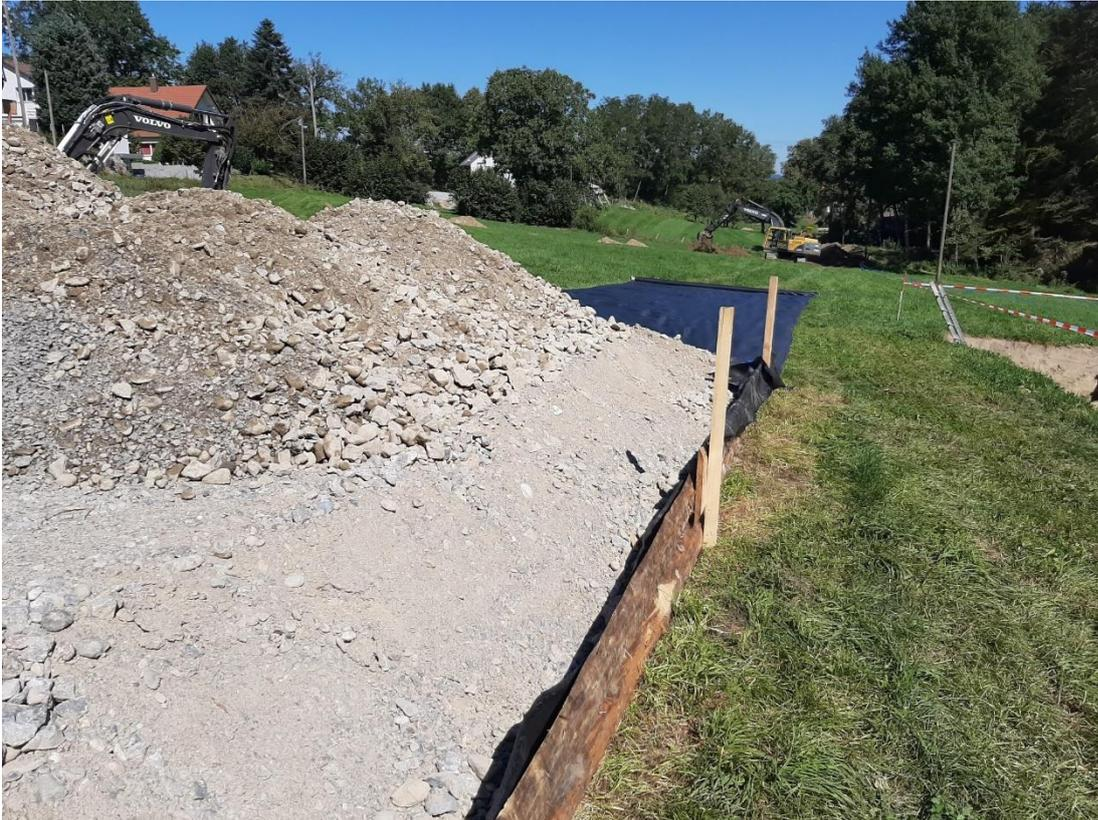
Abbildung 15: Sauberer Installationsplatz mit Schwartenbretter als Abschluss. Foto RSW AG
