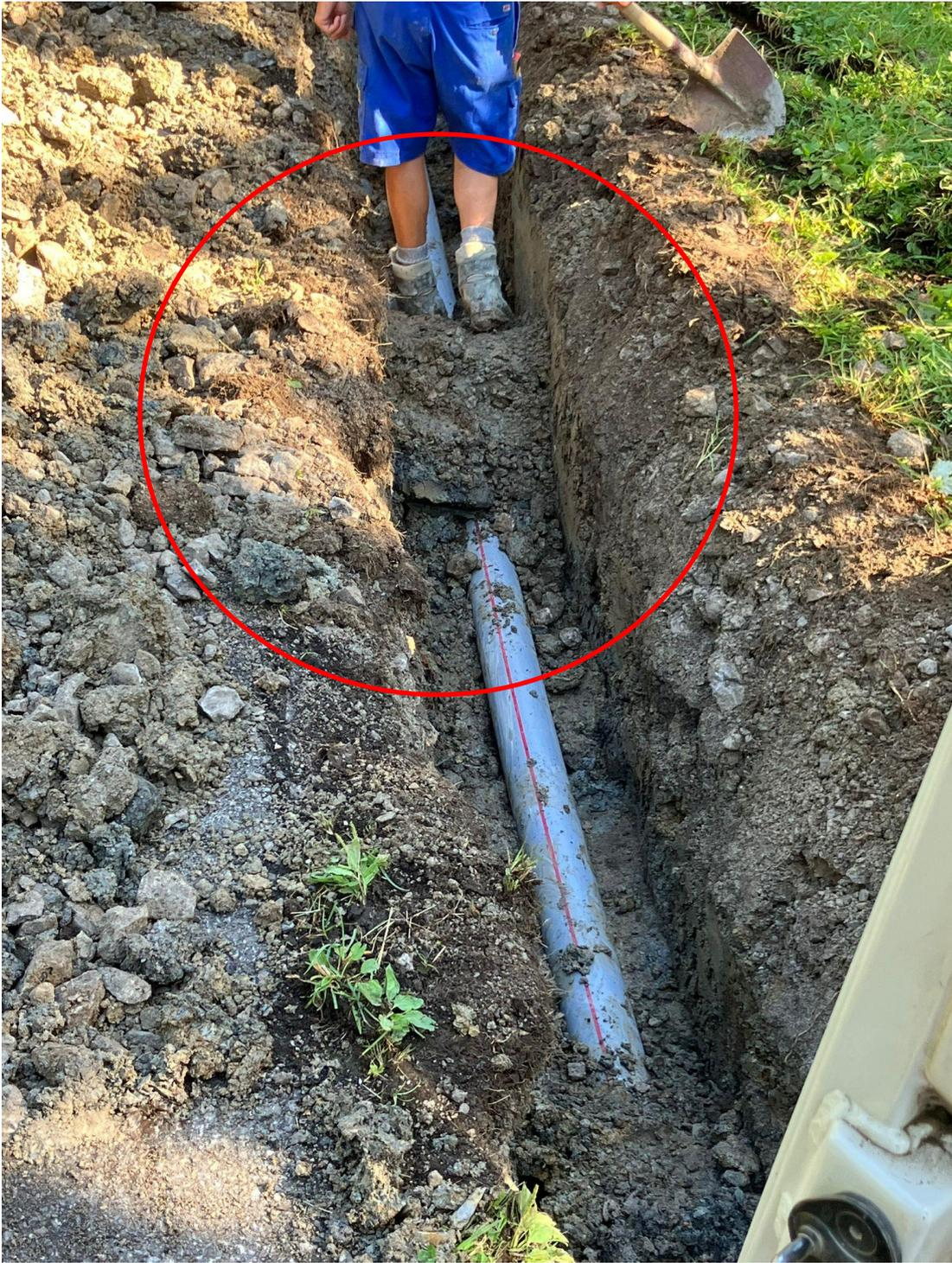
Abbildung 13: Sickerriegel im offenen Graben (ca. alle 15 m). Foto RSW AG.
