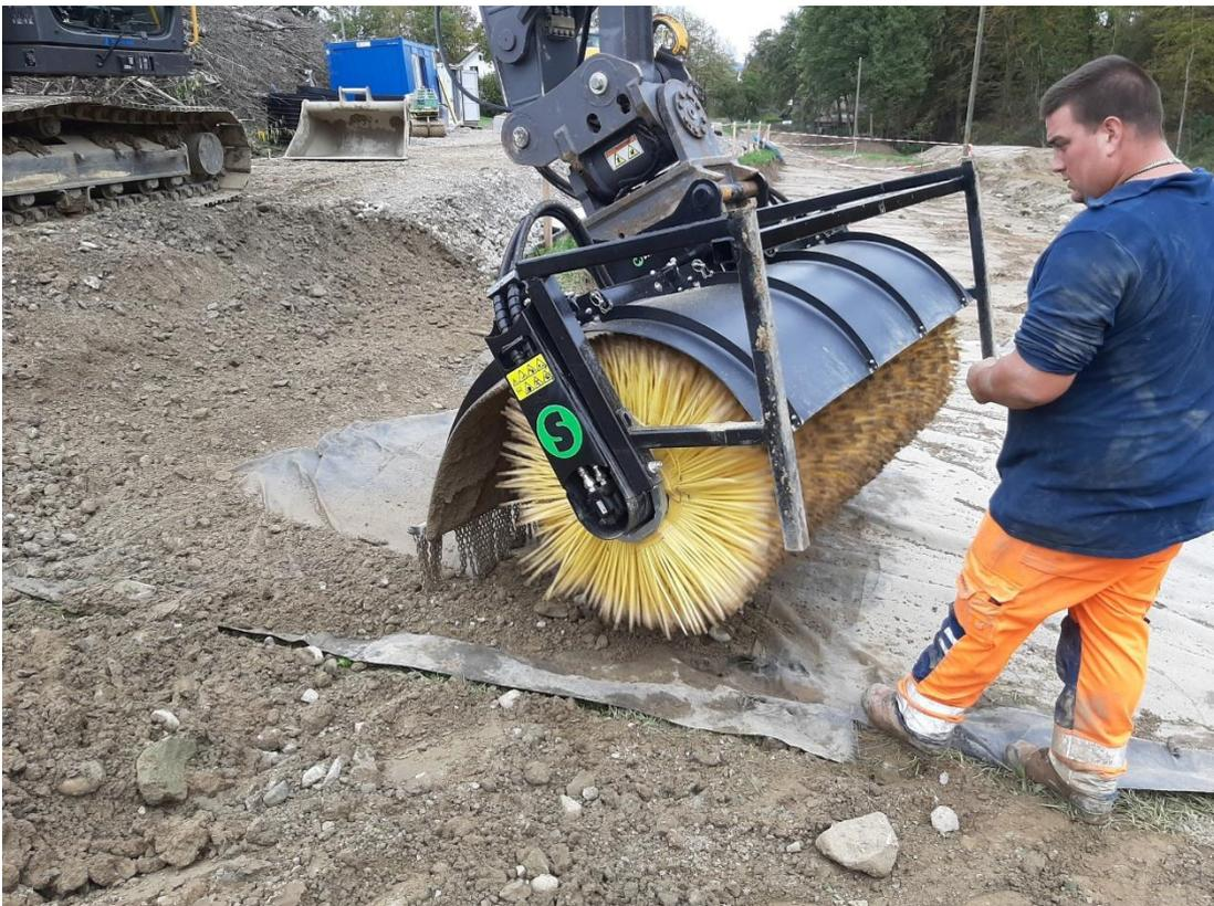
Abbildung 16: „Rückbaubürste“ für sauberen Rückbau und Wiederverwendung Geotextil. Foto RSW AG.
