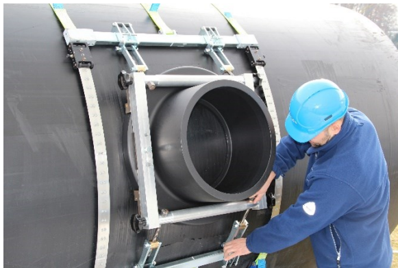
Grossrohrsattel d_a=2400\text{mm} Abgang d_a=500\text{mm}
