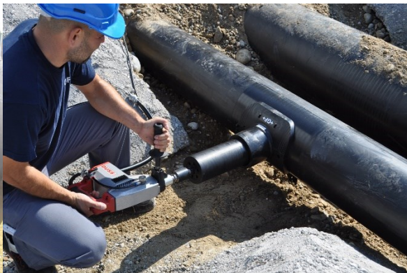
Grossrohr-Anbohrung Drucklos (Neubau)
