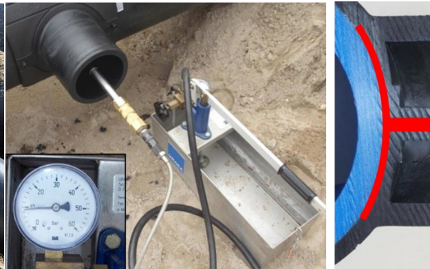
Dichtheitsprüfung Sattel für unter Betriebsdruck stehende Leitungen
