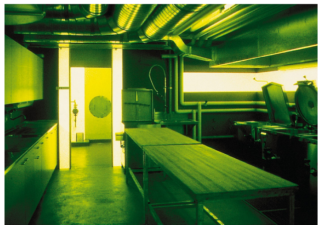
Bild 27 Raumbeleuchtung durch nachleuchtende Farben
