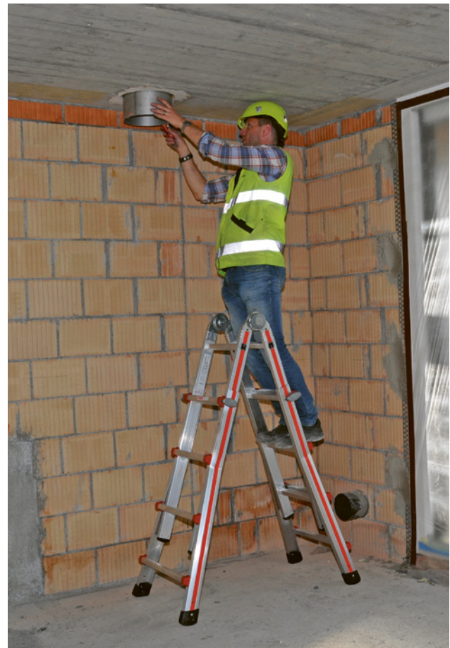
49 Kombileiter – als Anstelleiter, Bockleiter und Treppen-Bockleiter einsetzbar
