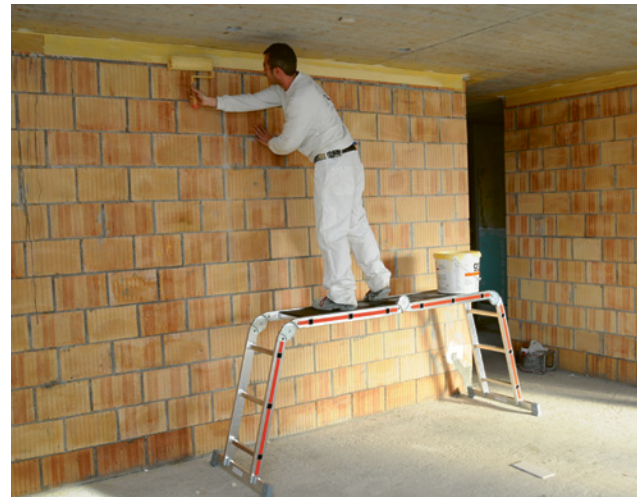
48 Mehrzweckleiter – auch als Arbeitsbühne einsetzbar
