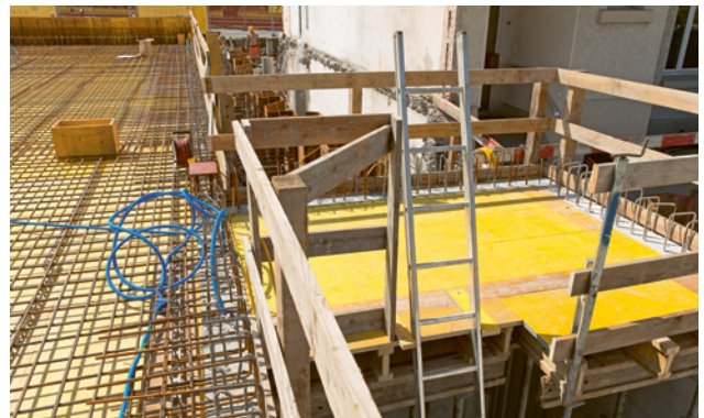
14 Die Leiter ragt mindestens 1 m über die Kante hinaus: ein sicherer Überstieg ist gewährleistet.
