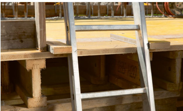
24 Seitliche Führung des Leiterkopfes
