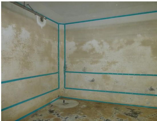
Anbringen der Klettbänder als Montagehilfe und Verlegen der Dichtungsbahnen
