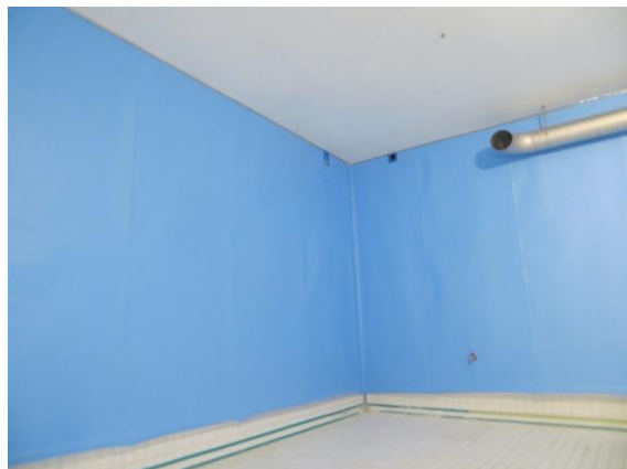
Anbringen der Klettbänder als Montagehilfe und Verlegen der Dichtungsbahnen
