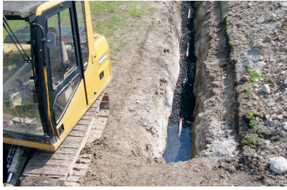
Montage einer Horizontalanode
