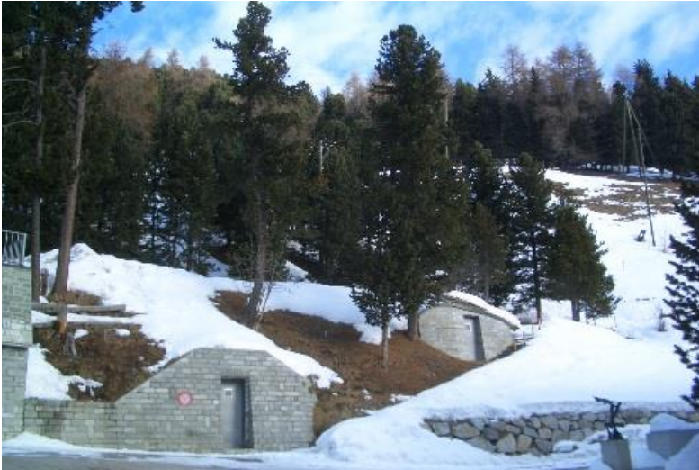
Altes Reservoir mit zwei Eingängen
