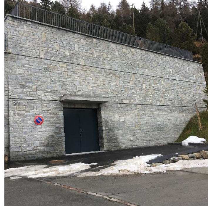
Neues Reservoir mit einem Eingang
