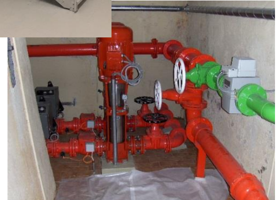
Rohrkeller im alten Reservoir
